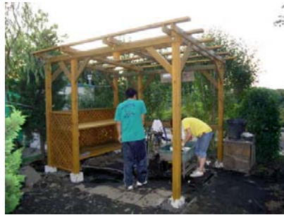
完成した井戸周り
